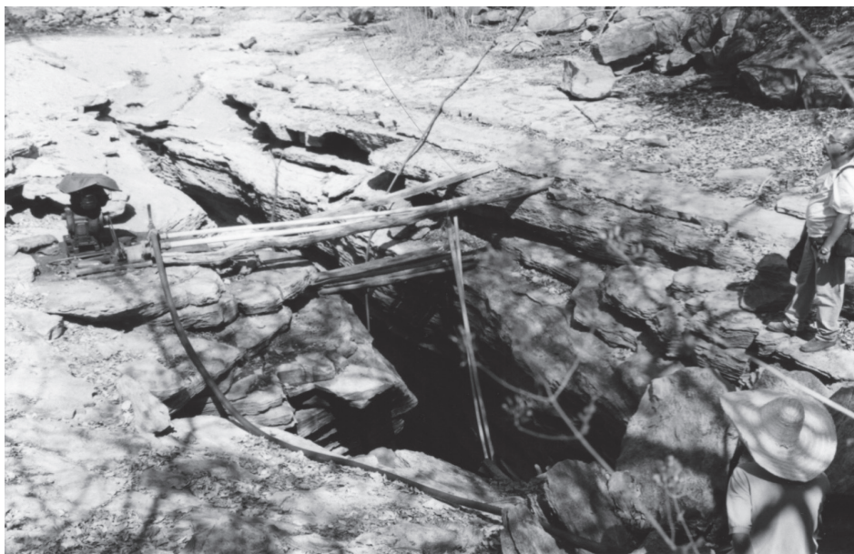
Figura 2. Fisuras verticales con acceso al agua subterránea que se usa en las casas del vecindario Fuente: Loredana Ribeiro, 2004.
