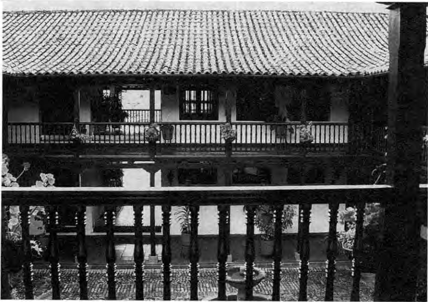
Imagen 2. Casa de las Cajas Reales: Casa donde funcionaron las Cajas y la Real Fundición de Pamplona (siglo XVIII). Fue restaurada y actualmente funciona allí el Servicio Nacional de Aprendizaje, SENA. Fotografía de María Eugenia Hernández (2003).
