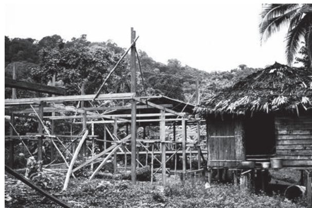
Fotografía 13. Sustrucción de la vivienda en palma. Huina, Bahía Solano
