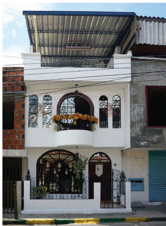
Fotografía 16. Vivienda urbana moderna Fuente: fotografía del archivo personal de Gilma Mosquera Torres y Jacques Aprile-Gnisset, 2010.
