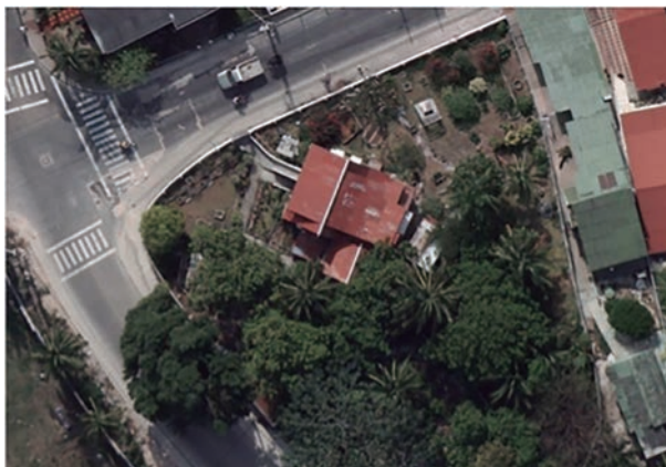
Fotografías 7. Fachada y planta, Casa Hemans Fuente: Aerofotografía de Google Earth, 2019.
