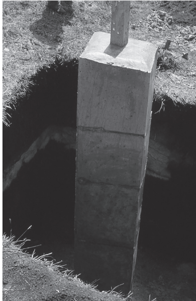
Figura 24. Cimiento de concreto, torre 19, donde se halló la tumba
