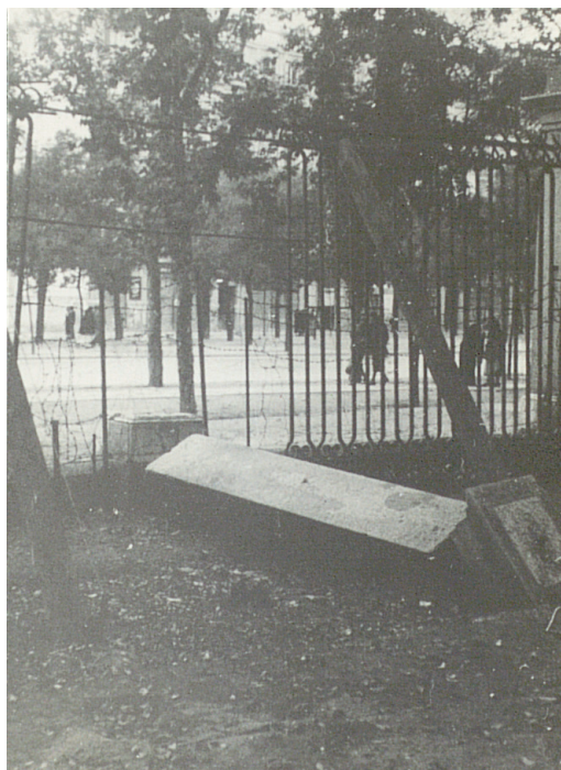
Figura 7. Daños en la valla del Real Jardín Botánico durante la Guerra Civil
