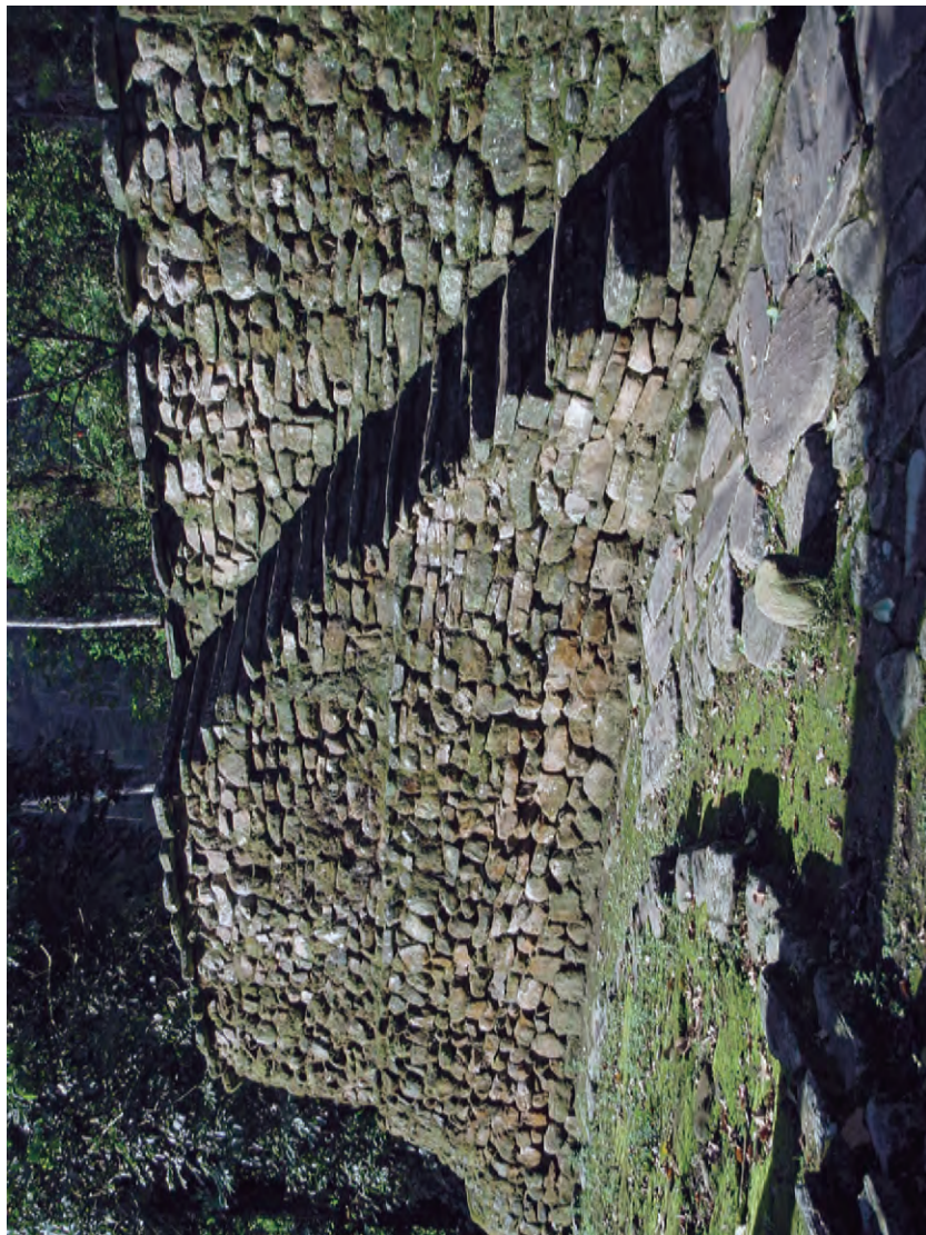
Lámina 1.5. Escalera de comunicación entre terrazas del eje central, Teyuna-Ciudad Perdida
