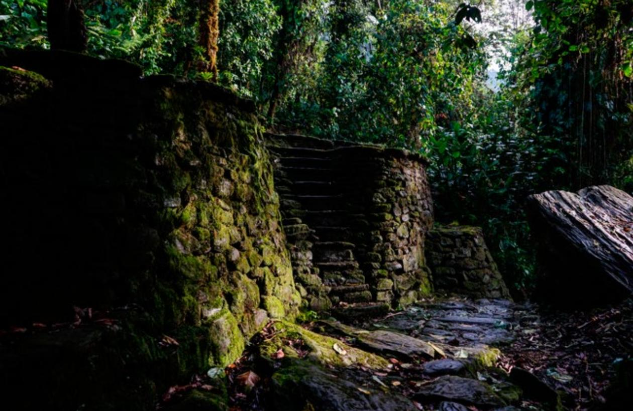
**Foto:** Santiago Giraldo. Terrazas del sector Piedras. Aquí se pueden observar los detalles constructivos relacionados con el manejo de aguas alrededor de las viviendas
