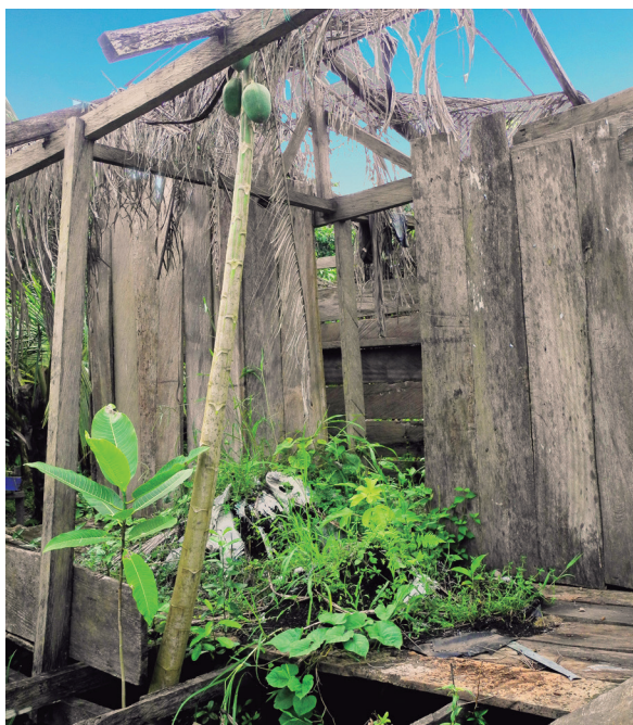
Figura 28. La forma de la corrosión
