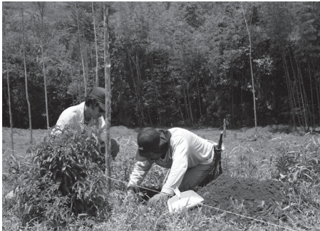
a) Excavación de pozo de sondeo
